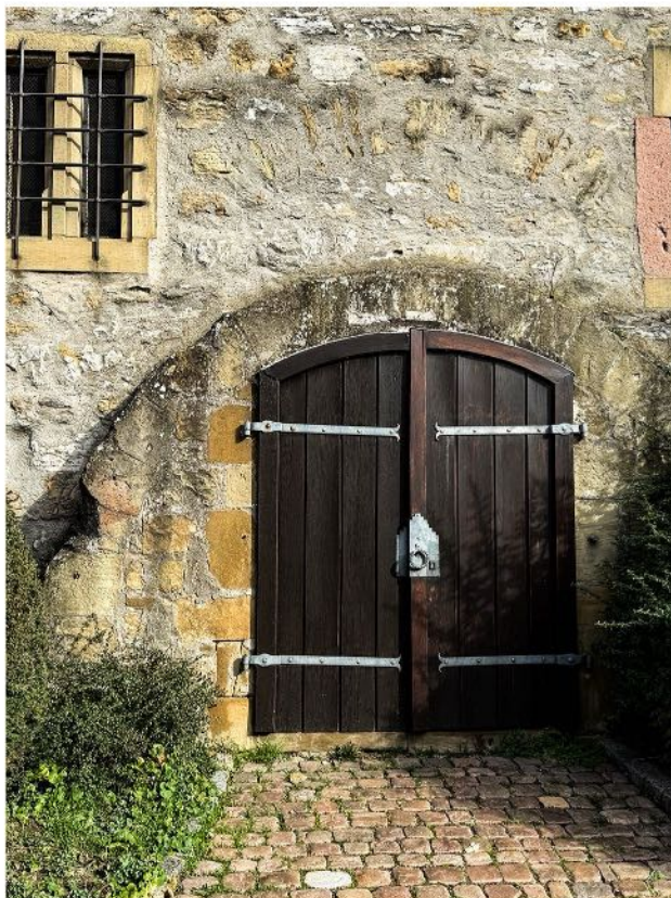
Das Kellertor mit zwei Bauphasen auf der Südseite des Steinhauses
