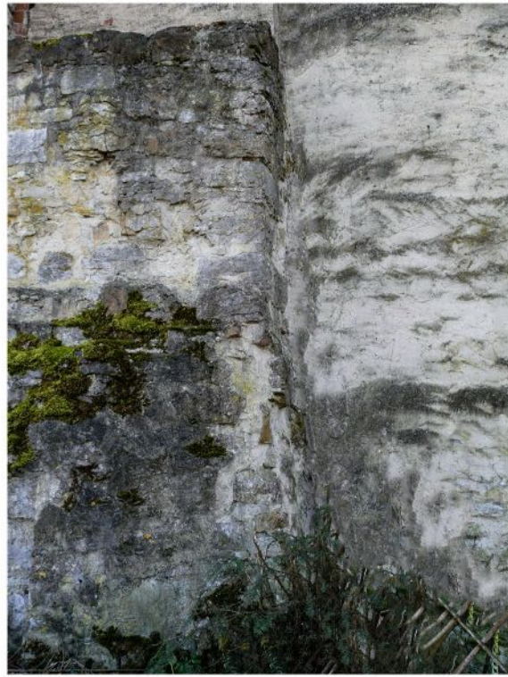
Der 3. Mauerknick zwischen den Häusern Burgviertel 3 und 5
