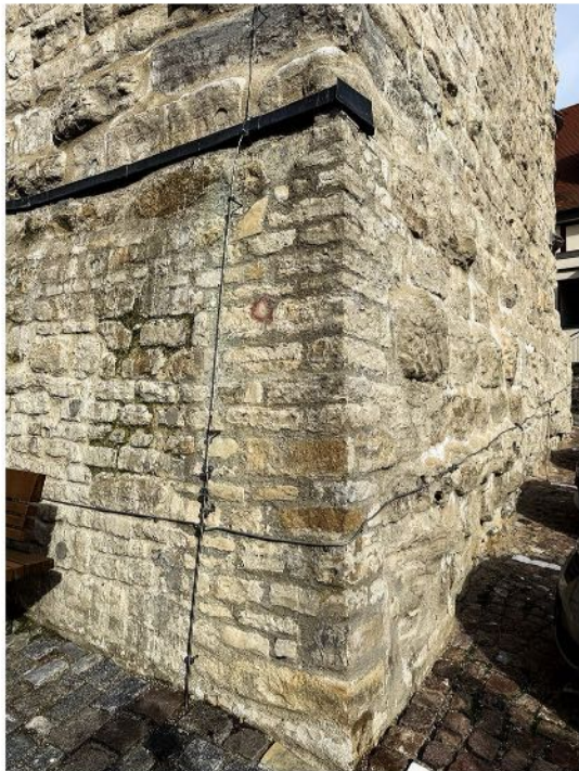
Verstärkung Ecke Süd-Ost
