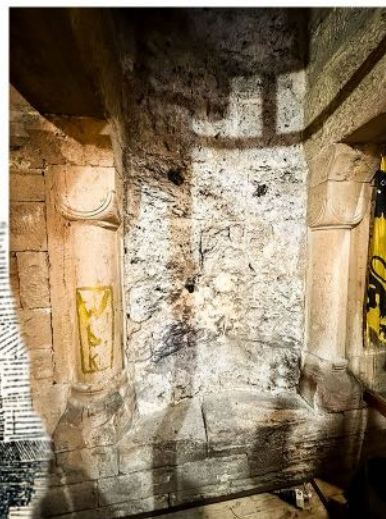
Der Kamin im heutigen Zustand von links aus gesehen
