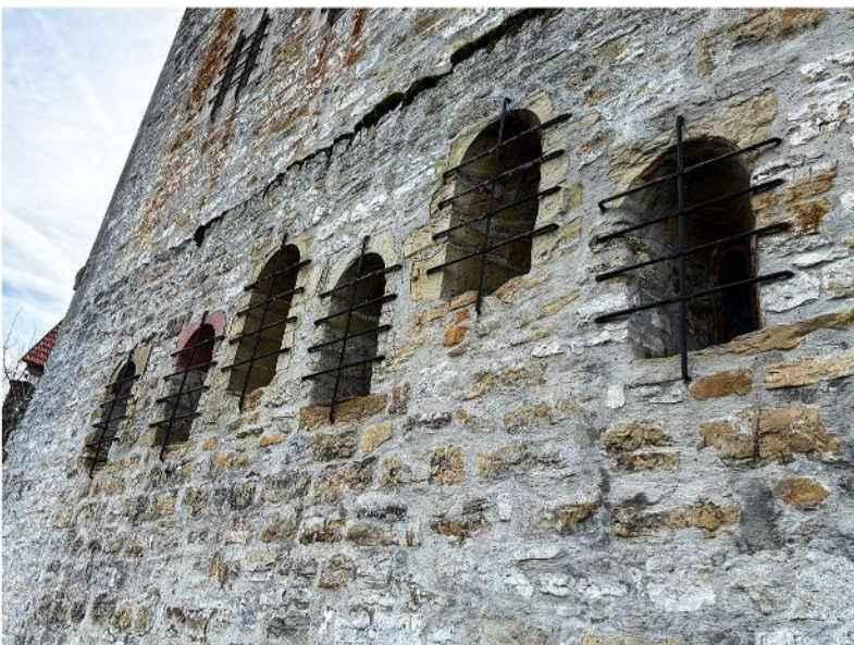
Die sechs unterschiedlich angeordneten Fenster am Steinhaus (vermutlich Rauchabzüge)
